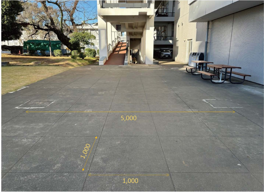
生田キャンパス A館前外構 5m × 5m モジュールの痕跡 © 大河内学
